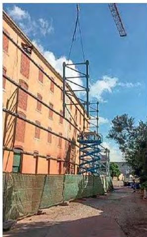
Figura 10. Montagem das Torres SHORFLEX® HD
