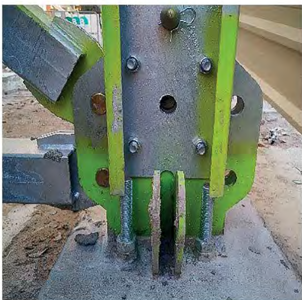
Figura 8. Fixação sapata ao maciço
